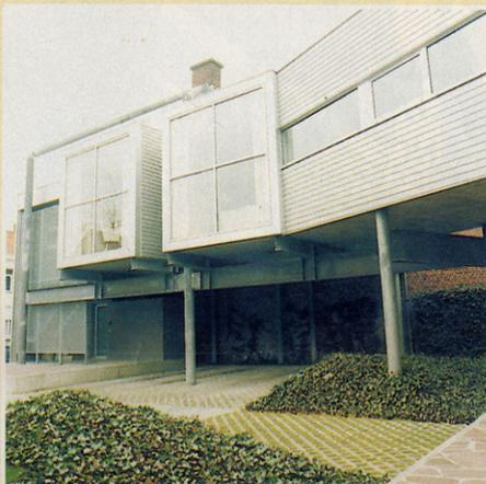
*La structure métallique et son remplissage de "caissons" habitables. (photo: M & M Fotodesian)*
