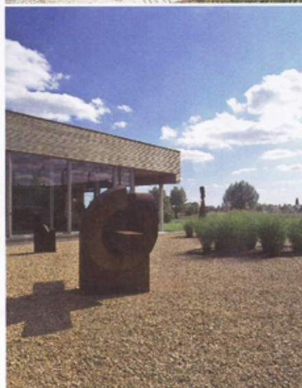
Denis Dujardin behield de structuur van de loods die een 'openluchtgalerie' moet worden. Weldra zullen de hopplanten rond de pijlers het gebinte overwoekeren.
